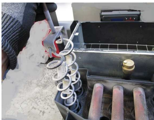
Fig. 99 - Sostituzione turbolatori se necessario
