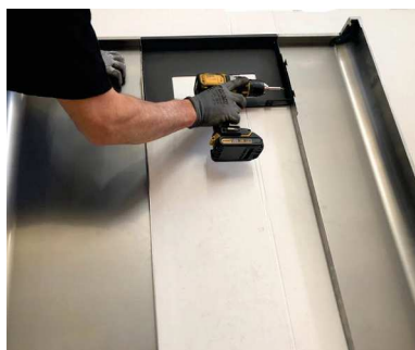
Fig. 34 - Fissaggio del montante
