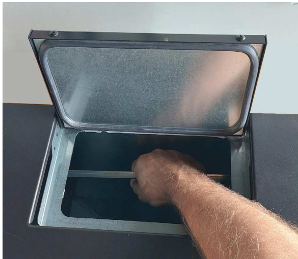
Fig. 21 - Leva per pulizia turbolatori
