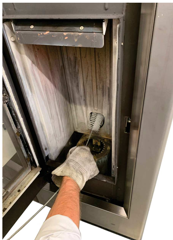
Fig. 72 - Reiniging met flessenwisser
