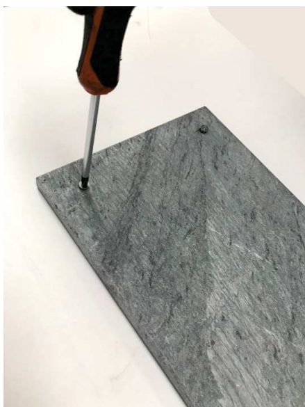
Fig. 33 - Draai de schroeven aan
