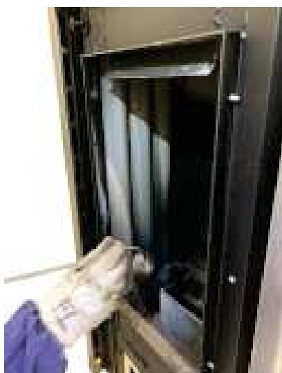
Fig. 63 - Reinig met pijpenwisser
