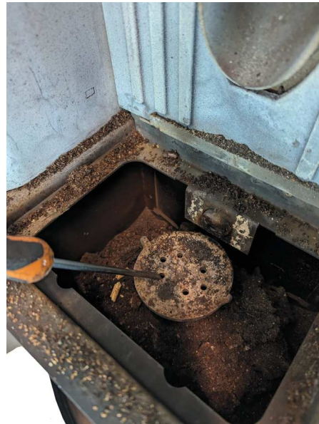
Fig. 30 - het schoonmaken van de vuurpot
