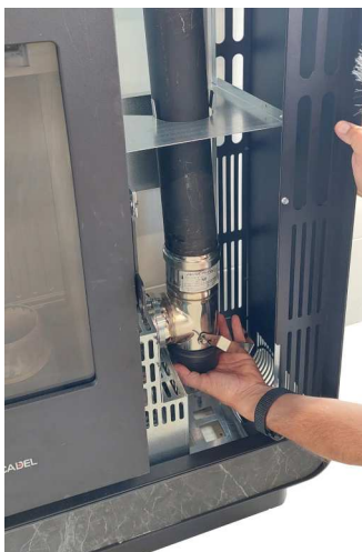
Fig. 61 - Limpieza canal de humos
