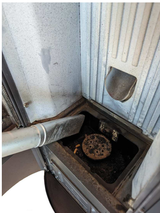
Fig. 76 - Limpieza alojamiento brasero
