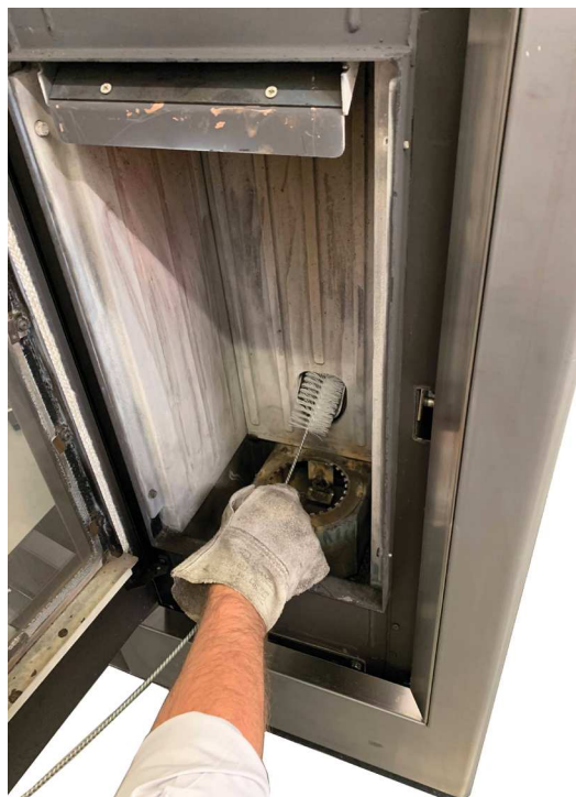
Fig. 77 - Limpieza con escobilla
