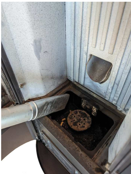
Fig. 31 - Limpieza alojamiento brasero
