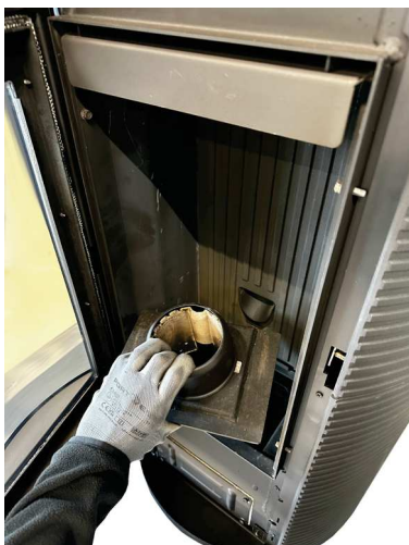
Fig. 72 - Brennschale entnehmen
