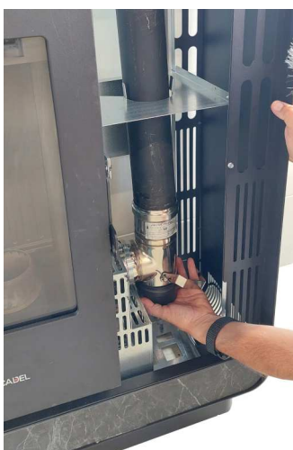
Fig. 59 - Fume conduit cleaning
