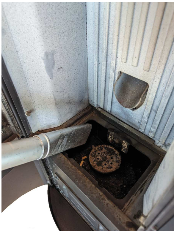
Fig. 88 - Nettoyage l'espace du brasero
