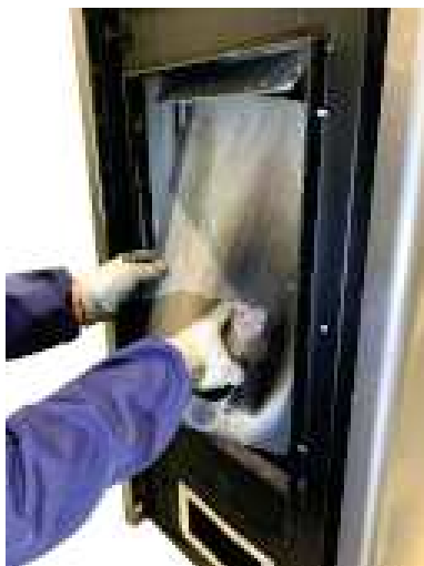
Fig. 78 - Retirer la paroi arrière du foyer
