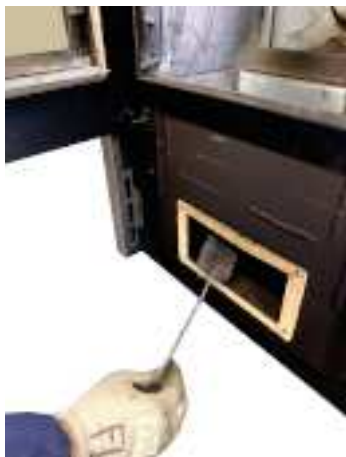
Fig. 71 - Nettoyer avec un goupillon
