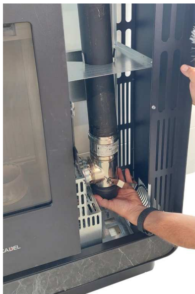
Fig. 73 - Nettoyage du conduit de fumée
