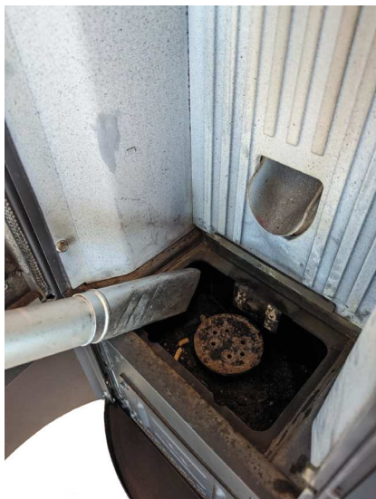
Fig. 31 - Nettoyage l'espace du brasero
