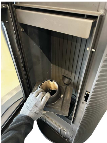
Fig. 29 - Extraction de le brasero
