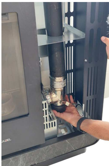
Fig. 59 - Pulizia canale da fumo
