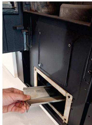
Fig. 70 - Rimuovere il deviatore fumi
