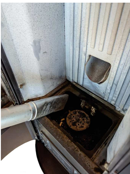
Fig. 31 - Pulizia vano braciere
