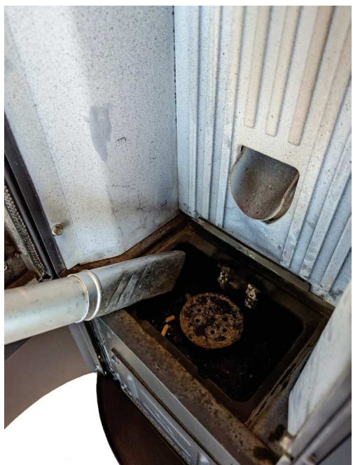
Fig. 40 - Rengøring af fyrfadsrum
