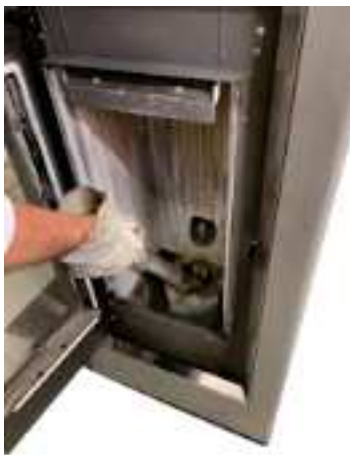
Fig. 36 - Rengøring af fyrfadsrum
