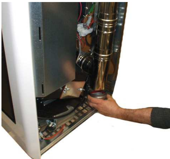
Fig. 40 - Reinigung des Rauchgaskanals
