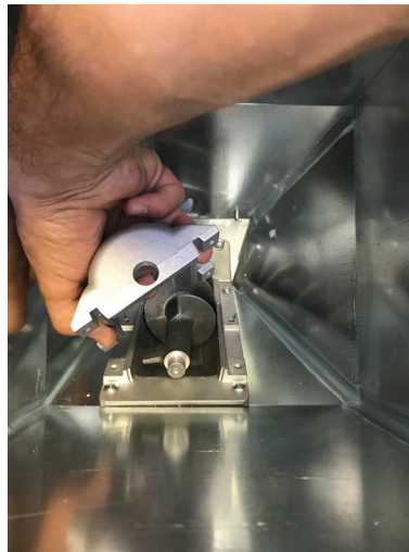
Fig. 20 - Gehäuse entfernen
