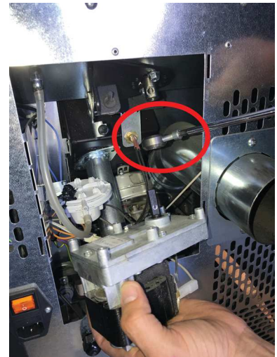
Fig. 21 - Getriebemotor entfernen
