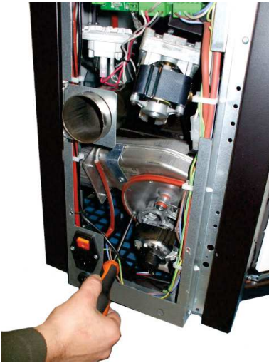
Fig. 24 - Reinigung Rauchgasansauggerät: Phase 1
