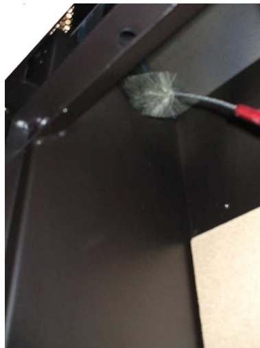
Fig. 44 - Nettoyage avec nettoie-pipes 1
