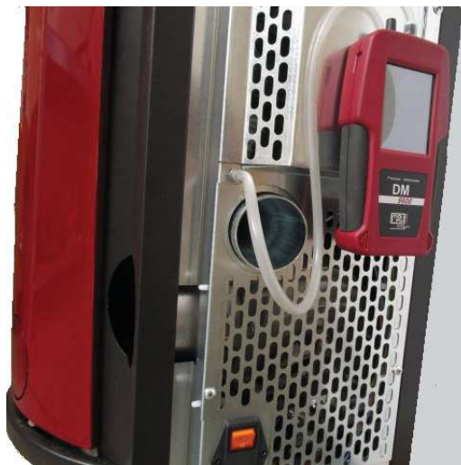
Fig. 26 - Connexion du pressostat numérique
