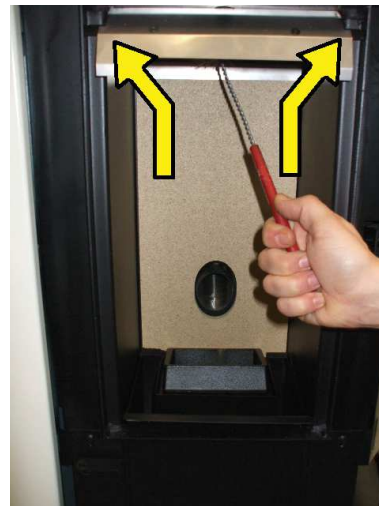
Fig. 45 - Nettoyer les deux conduits
