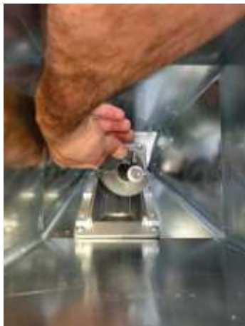
Fig. 31 - Retrait des spirales
