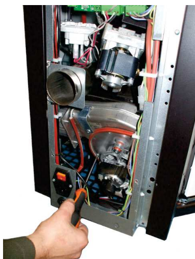
Fig. 33 - Nettoyage de l'aspirateur des fumées: phase 1
