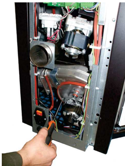
Fig. 24 - Pulizia aspiratore fumi: fase 1
