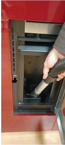
Fig. 44 - Nettoyage l'espace du brasero
