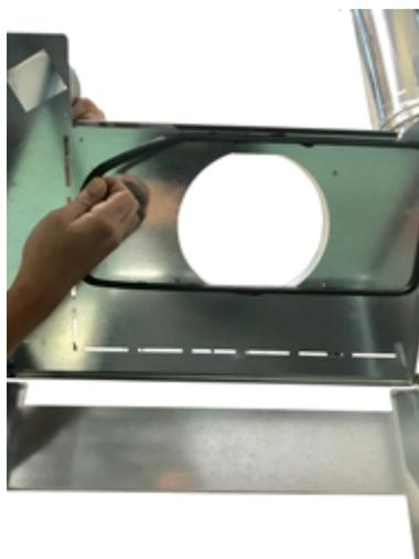
*Fig. 54 - Dichtung entfernen*
