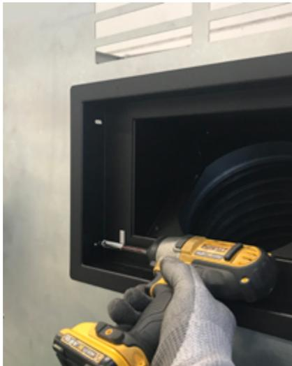
**Fig. 70 - Befestigung Ladeklappe außen**
