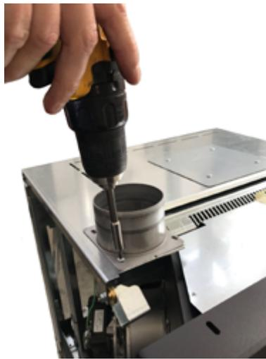
Fig. 48 - Den Anschluss befestigen
