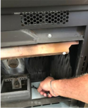
**Fig. 98 - Die Schrauben entfernen**
