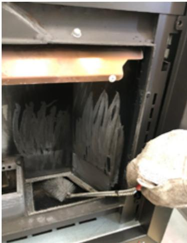
**Fig. 100 - Mit einer Rohrreinigungsbürste reinigen**
