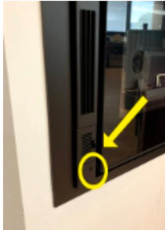
**Fig. 29 - Thermostatsonde**
