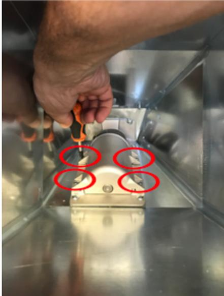
Fig. 87 - Lösen der Schrauben
