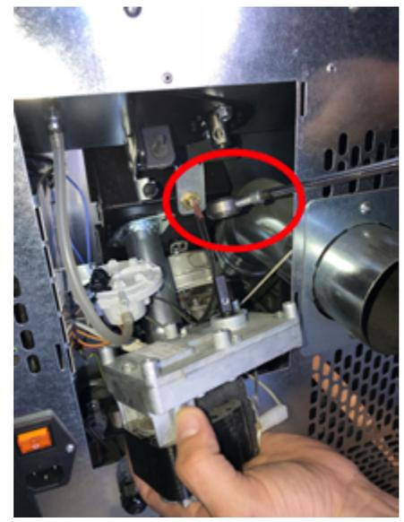
Fig. 89 - Getriebemotor entfernen
