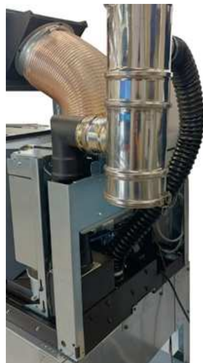
Fig. 80 - Aansluiting concentrische buis + verbrandingsluchtslang
