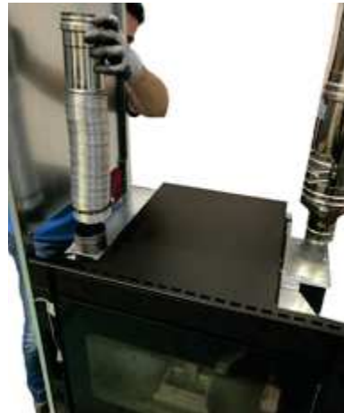
Fig. 63 - Plaatsing van het inbouwelement
