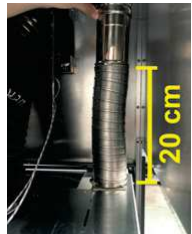
Fig. 49 - Aansluiting buigzame leiding (achter-aanzicht van het inzetstuk)
