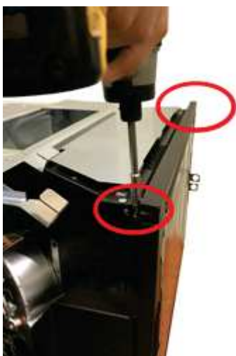
Fig. 53 - Verwijdering bovenste profiel
