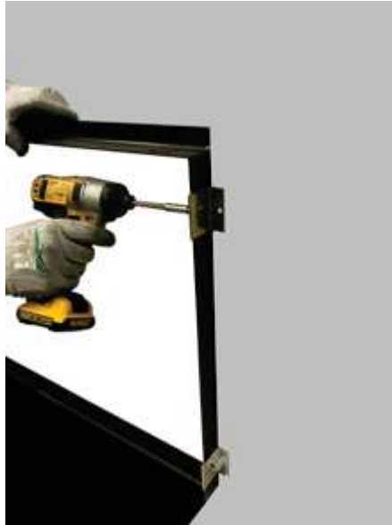
Fig. 77 - Bevestiging achteraan 1
