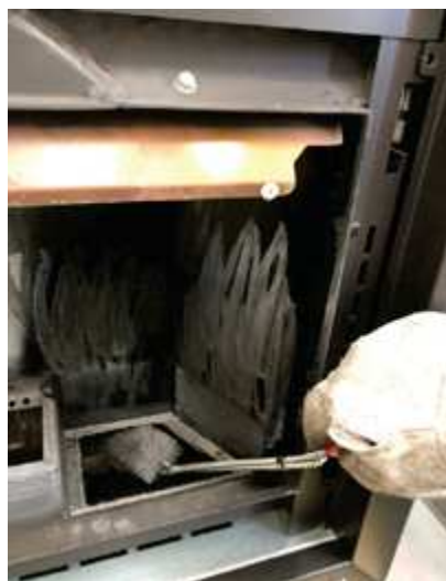
Fig. 100 - Reinig met pijpenwisser
