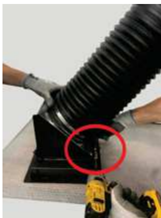
Fig. 65 - Span de klem
