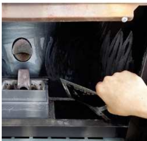
Fig. 99 - Verwijder de inspectiedop
