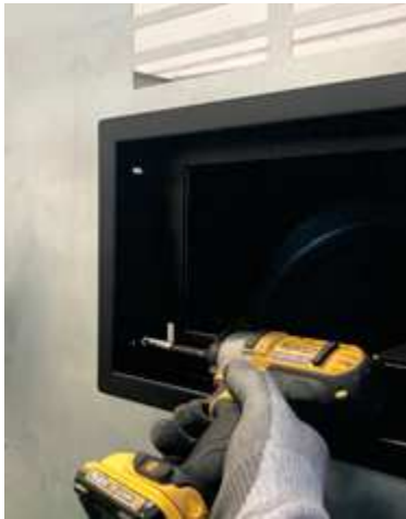
Fig. 70 - Externe bevestiging laadklep
