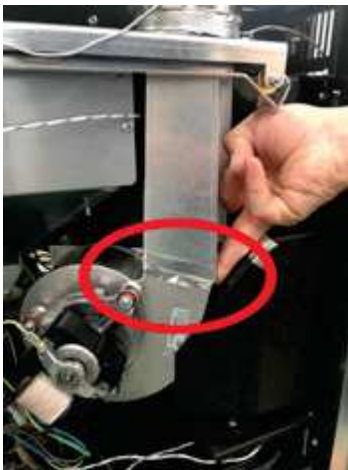
Fig. 47 - Met aluminium plakband verzegelen
