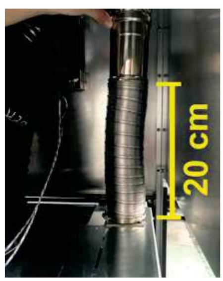
Fig. 58 - Raccordement du tube flexible (vue arrière de l'insert)
