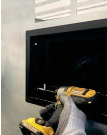
Fig. 79 - Fixation externe de la trappe
