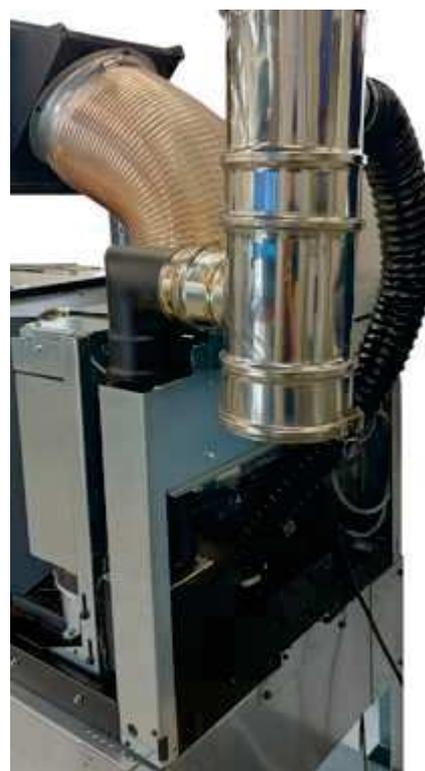
Fig. 89 - Raccordement du tuyau concentrique + raccord de l'air
