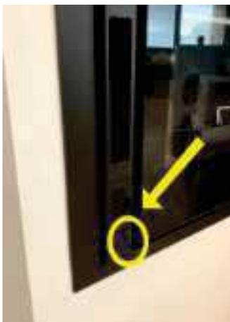
**Fig. 38 - Sonde de thermostat**
