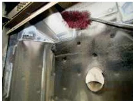
*Fig. 118 - Nettoyage avec un goupillon*
