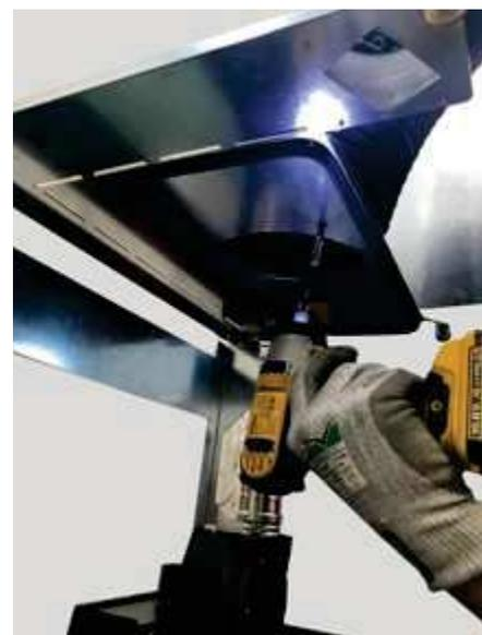
*Fig. 78 - Fixation du tuyau flexible*
