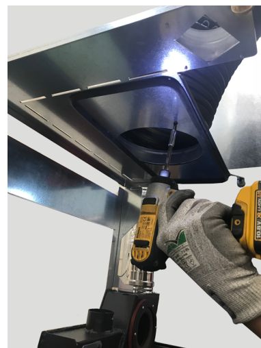
Fig. 69 - Fissaggio tubo flessibile
