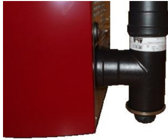
Fig. 25 - Reiniging rookleiding
