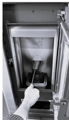
Fig. 33 - Reiniging met flessenwisser
