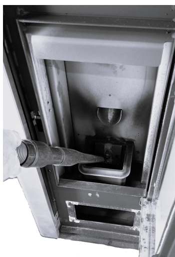
Fig. 32 - Reiniging ruimte vuurpot
