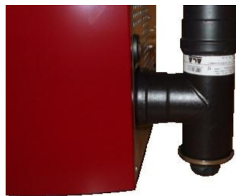
Fig. 25 - Reinigung des Rauchgaskanals
