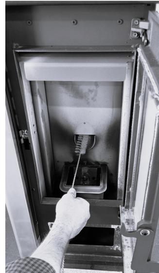
**Fig. 34 - Reinigung mit Flaschenbürste**
