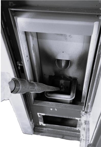
**Fig. 33 - Reinigung Fach Brennschale**
