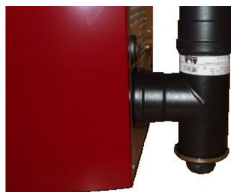
Fig. 25 - Fume conduit cleaning
