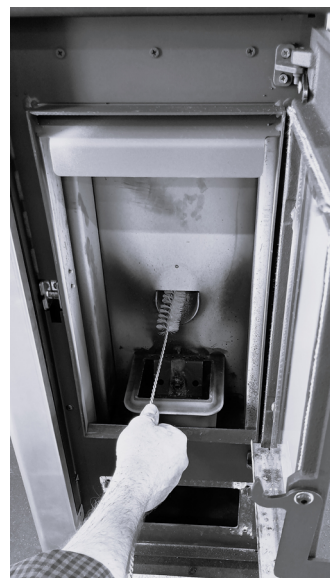
Fig. 33 - Nettoyage avec nettoie-pipes
