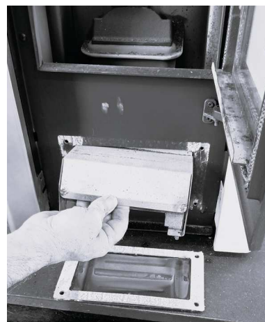
Fig. 31 - Rimuovere tappo ispezione
