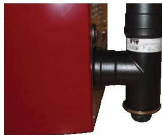
Fig. 25 - Pulizia canale da fumo
