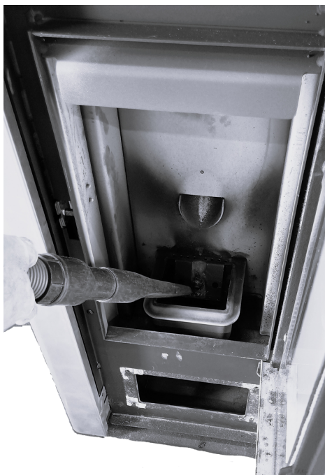
Fig. 41 - Limpieza alojamiento brasero
