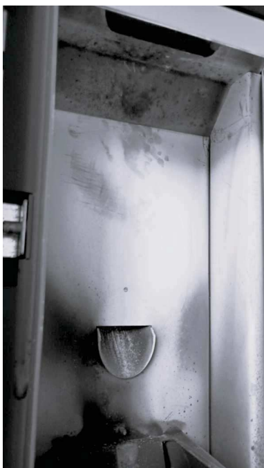
Fig. 22 - Die Stirnseite des Feuerraums 1 entfernen
