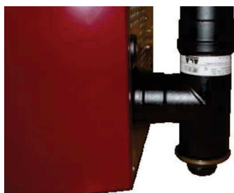
Fig. 21 - Reinigung des Rauchgaskanals
