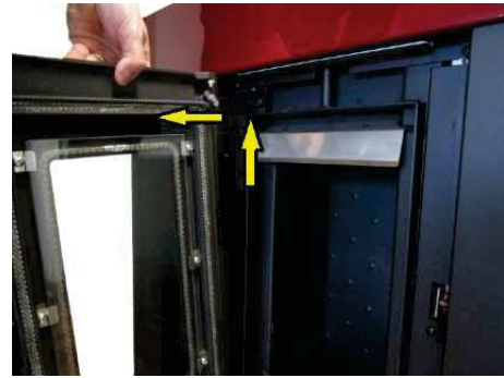
Fig. 12 - Ausbau der Tür
