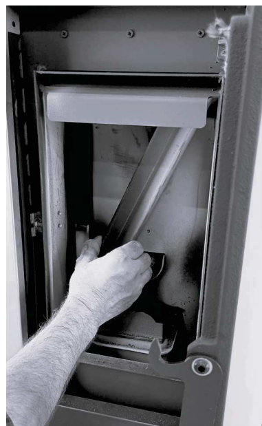
Fig. 24 - Die Rückseite des Feuerraums entfernen
