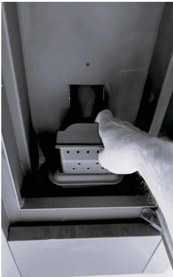
*Fig. 38 - Brennschale entnehmen*
