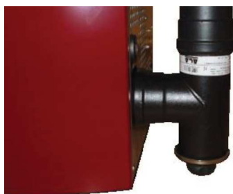
Fig. 30 - Nettoyage du conduit de fumée
