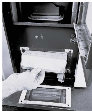
Fig. 36 - Retirer le bouchon d'inspection
