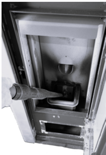
Fig. 39 - Nettoyage l'espace du brasero
