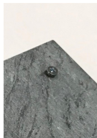
Fig. 37 - De schroef moet uitsteken
