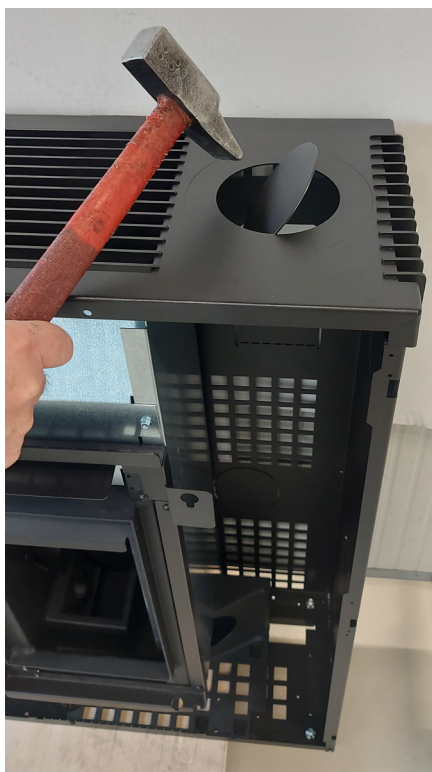
Fig. 69 - Verwijder het rooster
