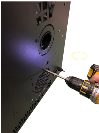
Fig. 92 - Verwijder de schroeven
