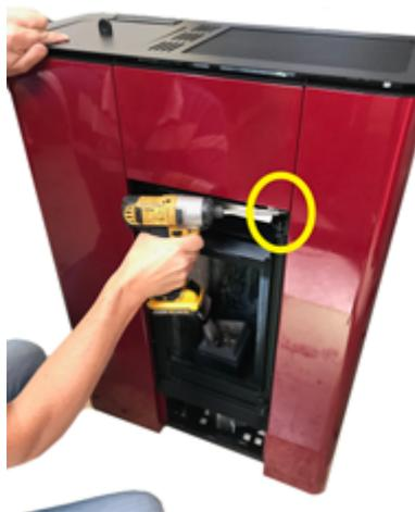
Fig. 53 - Extracción de los tornillos 1
