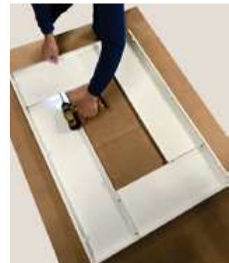
Fig. 32 - Fijación de los paneles 2
