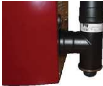
Fig. 88 - Limpieza canal de humos
