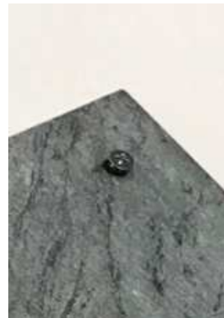
Fig. 39 - El tornillo debe sobresalir
