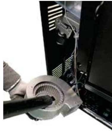
Fig. 96 - Limpieza del ventilador ambiente
