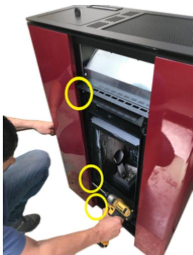
Fig. 55 - Extracción de los tornillos 3
