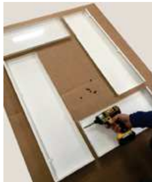
Fig. 31 - Fijación de los paneles 1
