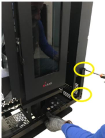
**Fig. 43 - Fijación de la abrazadera inferior**
