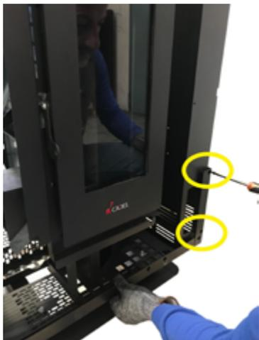
**Fig. 36 - Fijación de la abrazadera inferior**
