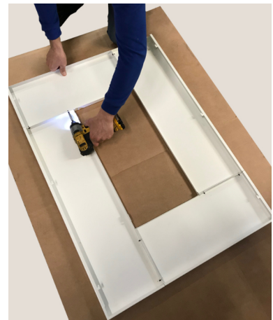
Fig. 30 - Befestigung der Platten 2
