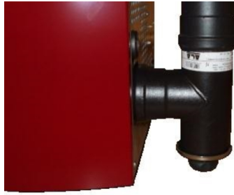
Fig. 87 - Reinigung des Rauchgaskanals
