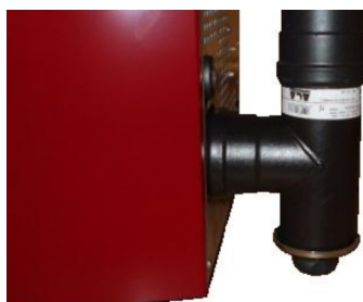
Fig. 96 - Nettoyage du conduit de fumée
