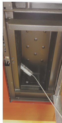
Fig. 37 - Nettoyage avec nettoie-pipes
