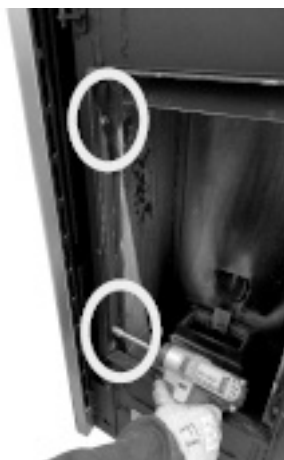
Fig. 57 - Extraiga los tornillos hexagonales
