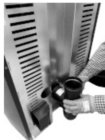
Fig. 24 - Conecte el racor en T
