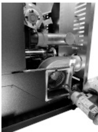
Fig. 36 - Extraiga los tornillos del ventilador
