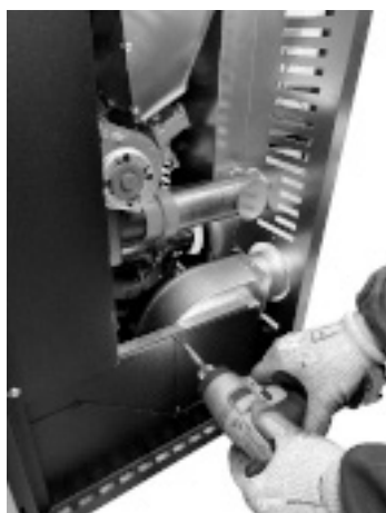
Fig. 35 - Retire la tapa
