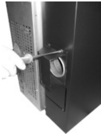
Fig. 50 - Montage du diffuseur
