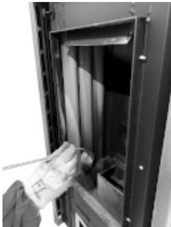
Fig. 68 - Nettoyer avec un goupillon
