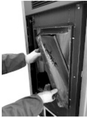
Fig. 66 - Ôter les parois latérales
