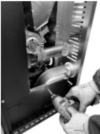
Fig. 42 - Positionnement des tuyaux pour la canalisation
