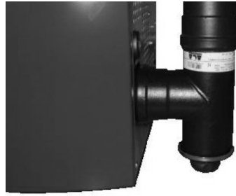
Fig. 61 - Nettoyage du conduit de fumée
