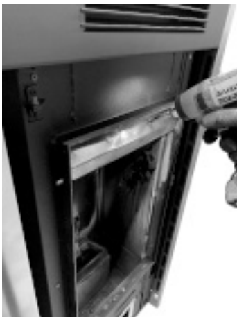
Fig. 62 - Retirer le déflecteur
