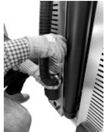
Fig. 37 - Raccorder le tuyau de l'air comburant
