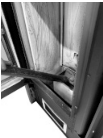
Fig. 35 - Nettoyage l'espace du brasero
