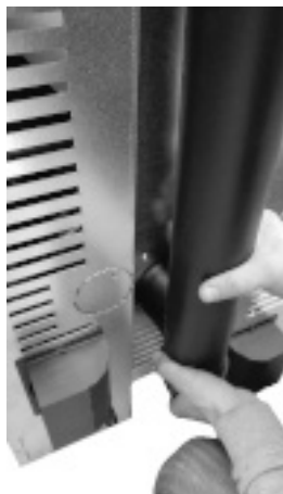
Fig. 27 - Innestare tubo d.80 mm
