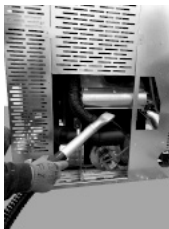
Fig. 67 - Pulizia ventilatore ambiente 2
