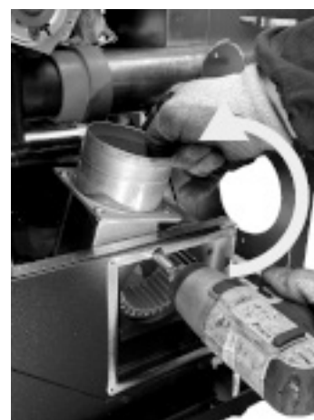
Fig. 35 - Ruotare ventilatore
