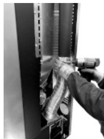
Fig. 38 - Fissare i tubi
