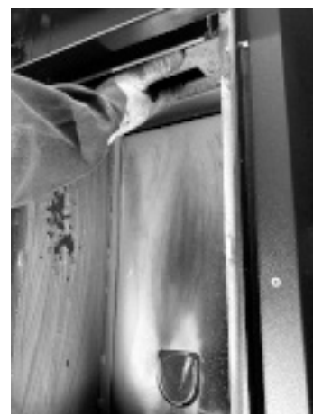
Fig. 56 - Rimuovere la testa del focolare 1
