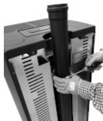
Fig. 25 - Scarico fumi posteriore montato
