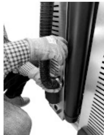
Fig. 28 - Innestare tubo dell'aria comburente
