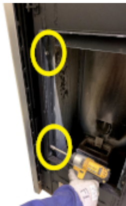
Fig. 46 - Verwijder de zeskantschroeven
