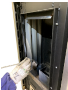
Fig. 51 - Reinig met pijpenwisser
