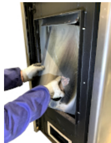
Fig. 50 - Verwijder het achterpaneel van de vuurhaard
