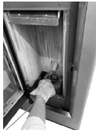
Fig. 39 - Reinigung mit Flaschenbürste
