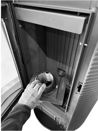
Fig. 36 - Brennschale entnehmen
