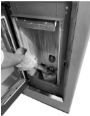
Fig. 34 - Nettoyage l'espace du brasero
