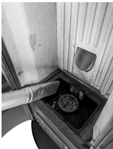
Fig. 38 - Nettoyage l'espace du brasero
