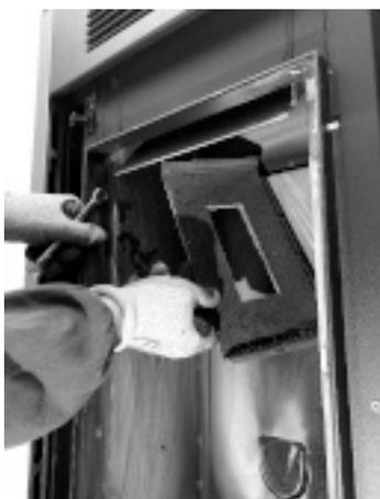
**Fig. 49 - Rimuovere la testa del focolare 2**
