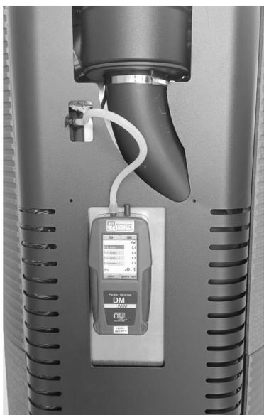
Fig. 36 - Collegamento pressostato digitale
