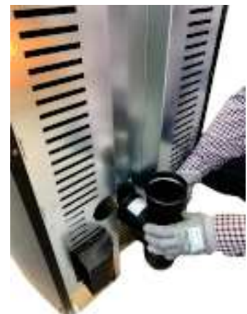
Fig. 24 - Conecte el racor en T
