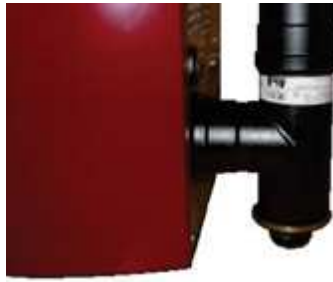
Fig. 56 - Limpieza canal de humos
