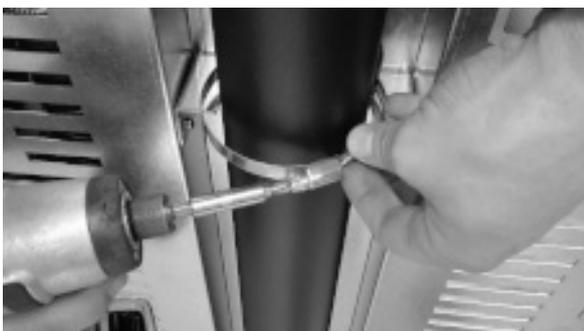
*Fig. 31 - Bloquee con la abrazadera*
