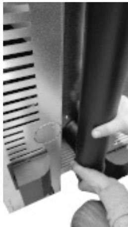
*Fig. 29 - Acople el tubo d.80 mm*
