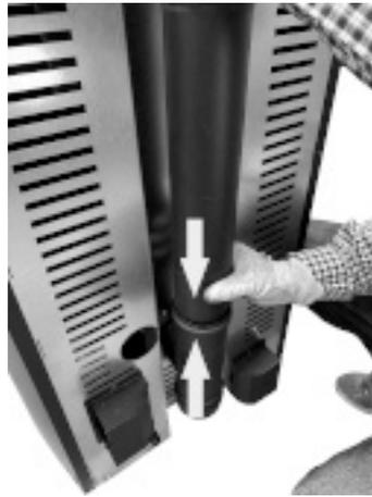
*Fig. 26 - Conecte los tubos*
