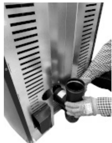
*Fig. 24 - Conecte el racor en T*
