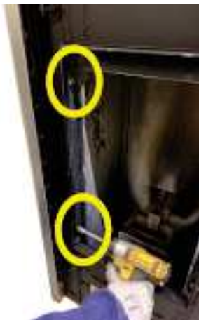
Fig. 57 - Extraiga los tornillos hexagonales
