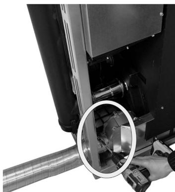
**Fig. 39 - Bloquee el tubo flexible**
