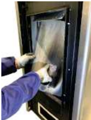
Fig. 60 - Extraiga la parte trasera del hogar
