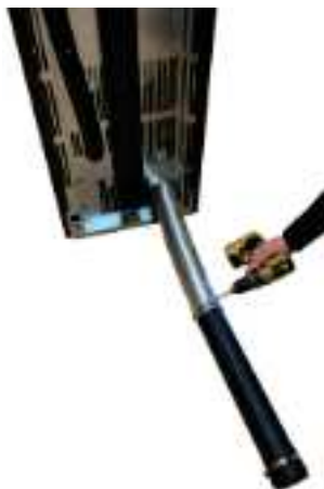
Fig. 40 - Conecte el tubo d. 80 mm
