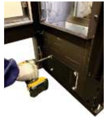
Fig. 53 - Retire la tapa
