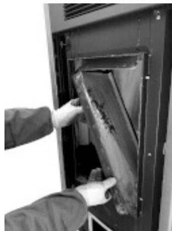
**Fig. 61 - Retire las paredes laterales**
