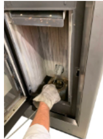
Fig. 33 - Limpieza con escobilla
