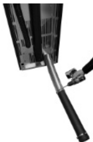
Fig. 38 - Rohr D. 80 mm anschließen
