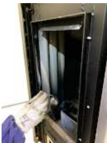
Fig. 60 - Mit einer Rohrreinigungsbürste reinigen
