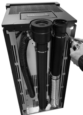
Fig. 40 - Schlauch D. 80 mm festspannen
