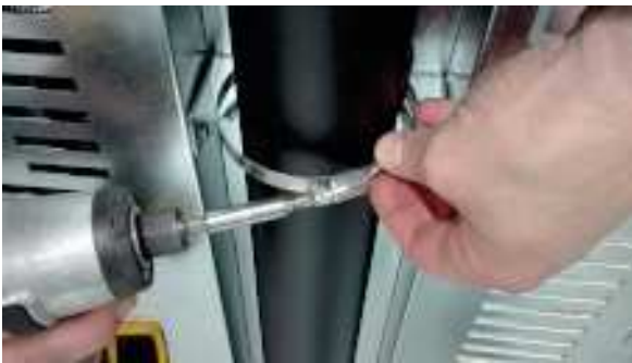
Fig. 29 - Mit Schellen fixieren
