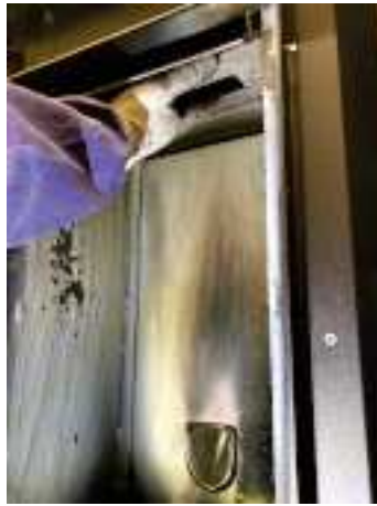
Fig. 56 - Die Stirnseite des Feuerraums 1 entfernen
