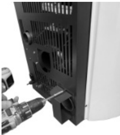
Fig. 32 - Umlenblech entfernen
