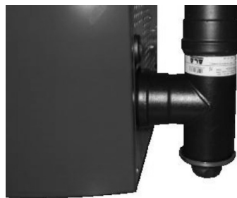
Fig. 54 - Reinigung des Rauchgaskanals
