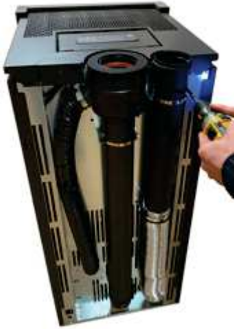
Fig. 40 - Schlauch D. 80 mm festspannen
