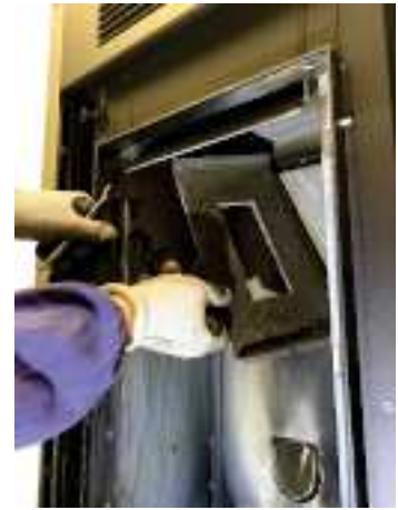
Fig. 57 - Die Stirnseite des Feuerraums 2 entfernen
