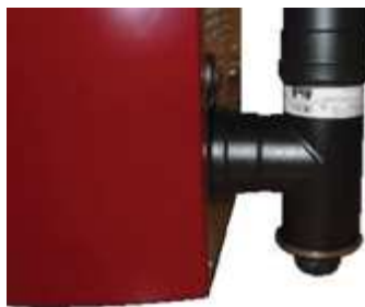
Fig. 54 - Reinigung des Rauchgaskanals
