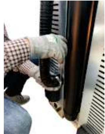
Fig. 28 - Rohr der Heizluft einstecken
