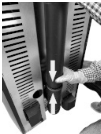
Fig. 24 - Die Rohre anschließen
