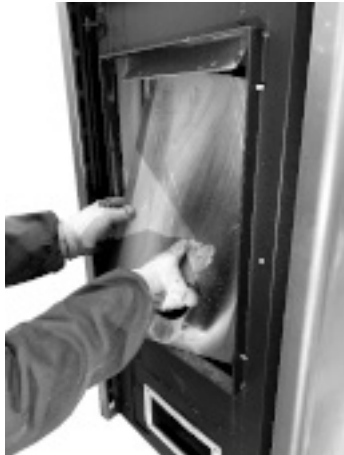
Fig. 58 - Die Rückseite des Feuerraums entfernen
