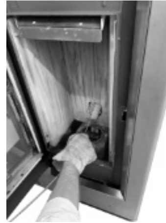
Fig. 33 - Reinigung mit Flaschenbürste
